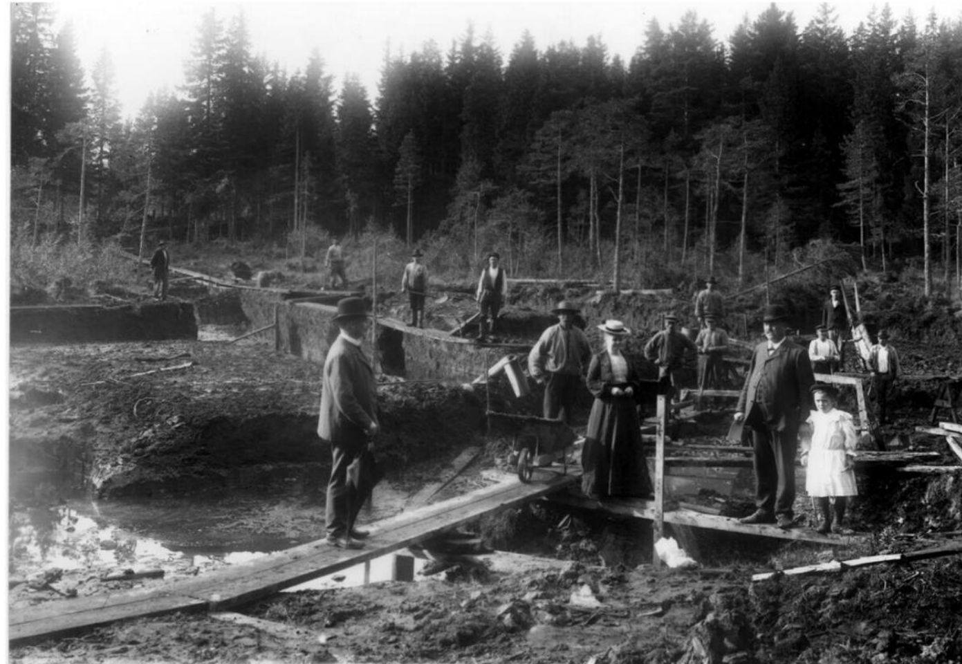
Grundgrävning inför trolig utdikning omkring år 1900. Foto: Västernorrlands museum / Kringla (PDM)
